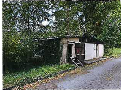
Außenansicht WC Anlage (Jugendclub)
