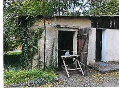
Eingang Lager (WC-Anlage)
